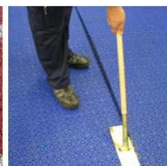
Bergo Demoneringsverktyg med skaft används vid större installationer när man vill flytta golvet.
